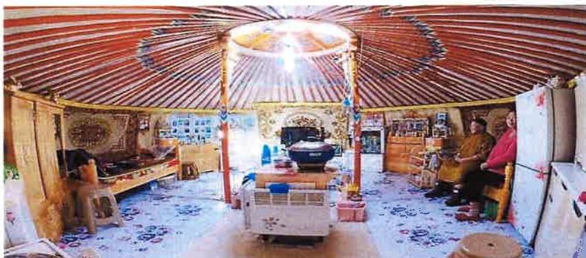
Зураг 36. Монгол гэрийн дулаалгын төслийн хүрээнд цахилгааны халаагуур суурилуулсан байдал
