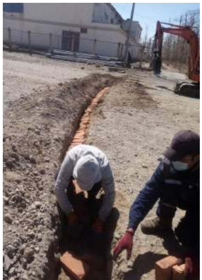
9. 1-40 АЙЛЫН ЦТП БОЛОН 86-ГИЙН ЦТП-ГИЙН ЦАХИЛГААНЫ ТЭЖЭЭЛИЙН КАБЕЛУУДЫГ ӨРГӨТГӨН ШИНЭЧЛЭВ
