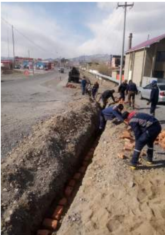
9. 1-40 АЙЛЫН ЦТП БОЛОН 86-ГИЙН ЦТП-ГИЙН ЦАХИЛГААНЫ ТЭЖЭЭЛИЙН КАБЕЛУУДЫГ ӨРГӨТГӨН ШИНЭЧЛЭВ
